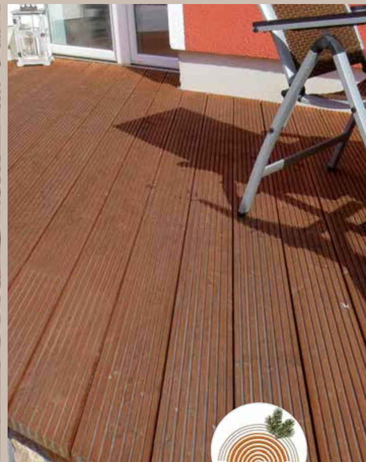
Kombi-Bodendiele aus Douglasie 2,7 cm stark, 14,6 cm breit, roh, beide Breitseiten unterschiedlich geriffelt.
