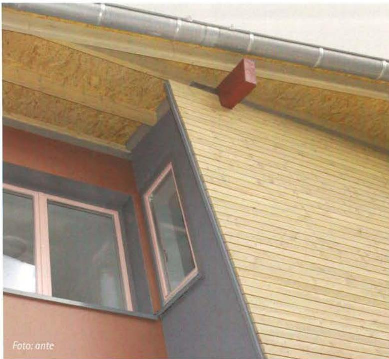
*Wetterschutz: Für belüftete Vorhangfassaden wird (übereinstimmend mit DIN 18516) eine durchgehende Belüftungsebene  $\geq 20$  mm sowie Zu- und Abluftöffnungen von  $\geq 50$  cm<sup>2</sup>/ lfdm Wandlänge gefordert. Ausnahmen: Vorhangfassaden mit Kleinformaten, die aufgrund ihrer Kleinteiligkeit einen großen Fugenanteil haben. Wenn auf die Wandaußenseite (bzw. Dämmung) eine Wasser ableitende Schicht aufgebracht wird ( $s_d \leq 0,3$  m) darf auf Be- und Entlüftung verzichtet werden.*
