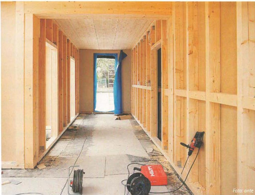
Bewährte, nach außen diffusionsoffenen konstruierte Bauteile erfüllen die Forderungen der Norm nach Rück-trocknungskapazitäten für den Fall un-planmäßiger Feuchte im Querschnitt. Diese nachweisfreien Konstruktionen (GK 0) sind zukünftig im Anhang der neuen DIN 68800 aufgeführt.
