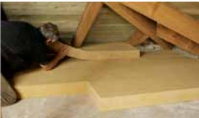
Mit den stabilen STEICOtop Dämmplatten lassen sich schnell große Flächen dämmen. Der Anschluss an Details wie Fußpfetten gelingt passgenau. Da die Platten glattkantig sind, müssen bei STEICOtop Randstücken keine Plattenprofile beigearbeitet werden; schwieriges Einpassen unter beengten Platzverhältnissen entfällt. Wird zweilagig gearbeitet, empfiehlt sich die Verlegung mit Stoßfugenversatz.
